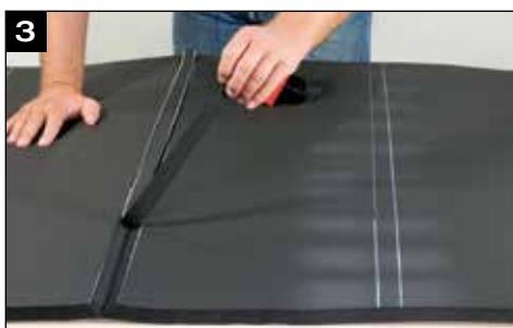
De ontstane voegen met behulp van een lijmpomp met Kaiflex speciale lijm voorzien en laten drogen.
