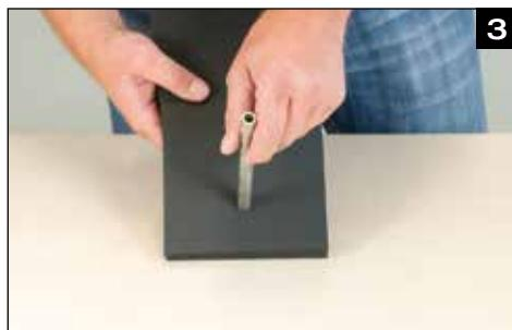
Isolatiestrips snijden: De lengte moet overeenstemmen met de omtrek van de isolerende slang + minimaal de isolatiedikte. Opening voor het ophangen (plugschroef) maken (ponsen).
