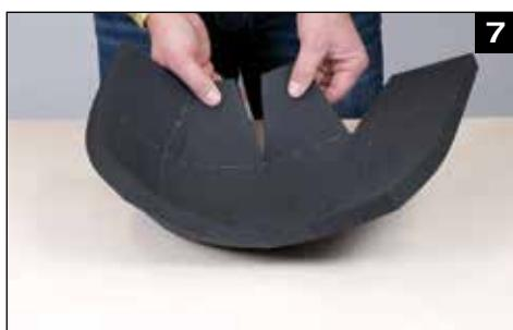
Montage van het enkele bochtstuk. Verlijm de lengte en sijnnaden. Zet de buisisolatie met Kaiflex materiaal door. Installation du coude d'une pièce. Collage des joints longitudinaux et bord à bord. Poursuivre l'isolation du tuyau avec le matériel Kaiflex.
