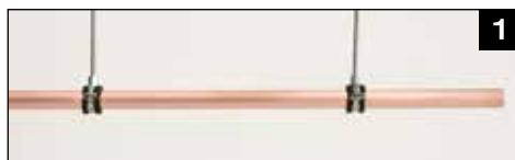
De isolatiemanchet monteren en de klem aanbrengen, let op voldoende vastzetten van de klem
