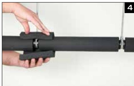
De isolatiestrips monteren en de lengtenaad, net als de verticale uitsparing voor de klembevestiging (draadeind), met Kaiflex speciale lijm verlijmen.
