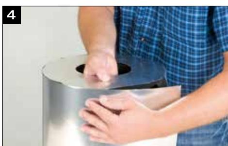
De schuine vlakken van de plaat en de mantel met Kaiflex speciale lijm insmeren en verlijmen.
