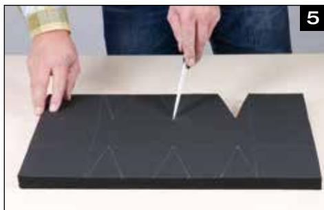
De berekende waarden X en Y nemen en de lange zijde van de Kaiflex plaat (Le) in wisselende lengtes van Y en X delen – zoals in de tekening beschreven.
