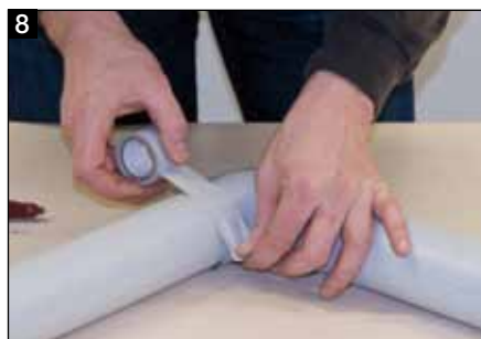
8 Stoßstellen mit PVC Klebeband verkleben
