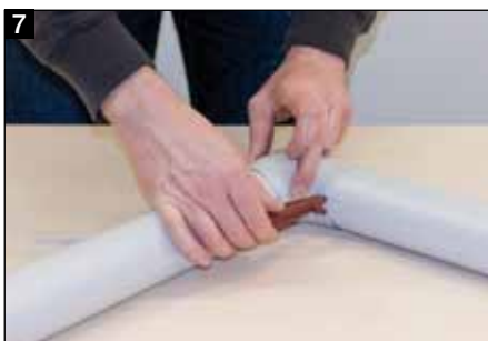
7 Evtl. Fixierung durch Nieten mit Hilfe eines Nietenstechers
