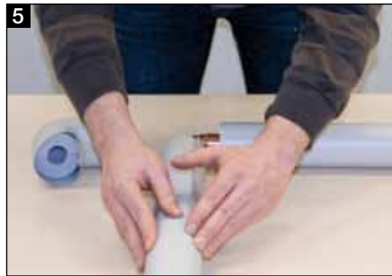
5 Gleichmäßiges Andrücken der Überlappung (auf Spannungsfreiheit achten – nicht auf Zug arbeiten)
