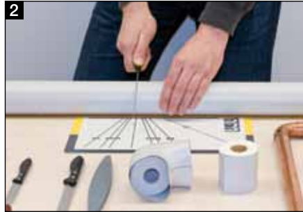
2 Zuschneiden der KAIFOAM PUR Schalen
