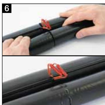
*Dämmung an den Klebefläche zusammenpressen. Darauf achten, dass die Kabel nicht mit verklebt werden.*
