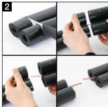
*Dämmung an jeder Stirnseite um mindestens 5 cm kürzen, damit das Kabel 5 cm frei liegt.*
