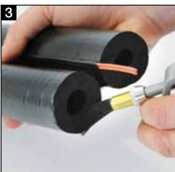
*Stirnseiten der Dämmung mit EPDM Kleber einstreichen.*
