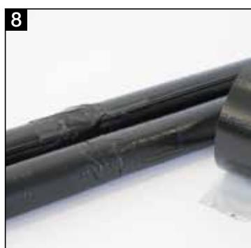
*Abkleben der Kontakte und der Verbindung mit schwarzem Gewebeband.*
